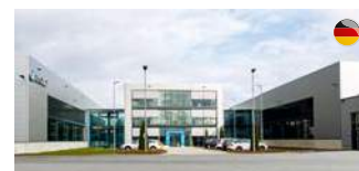
ARNOLD UMFORMTECHNIK Dörzbach Germany
