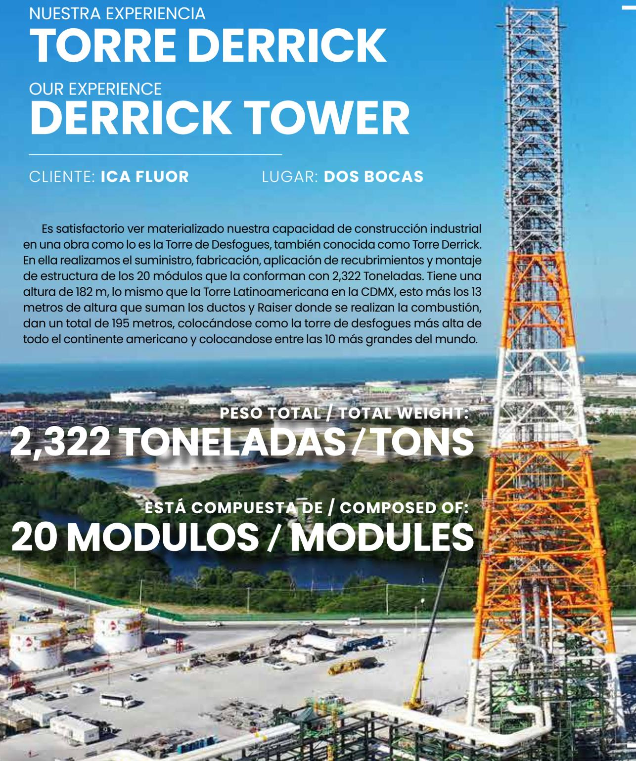
En su base tiene 3 tanques de sello líquido de 24.5 Toneladas cada uno, que manufacturamos y montamos con código de material SA-516-60 .
