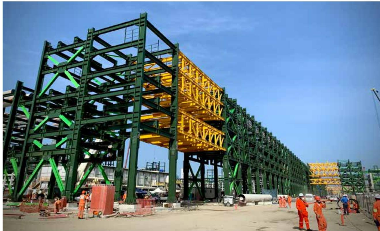
El Rack de Integración de Tuberías y Puentes de Interconexión también fueron obra nuestra y una de las cumbres de toda la refinería, pues recorren prácticamente todo el predio de la misma; desarrollamos el suministro, fabricación, aplicación de recubrimiento, embarque y montaje de estructura metálica pesada y semipesada, resultando 15,000 Toneladas totales.
